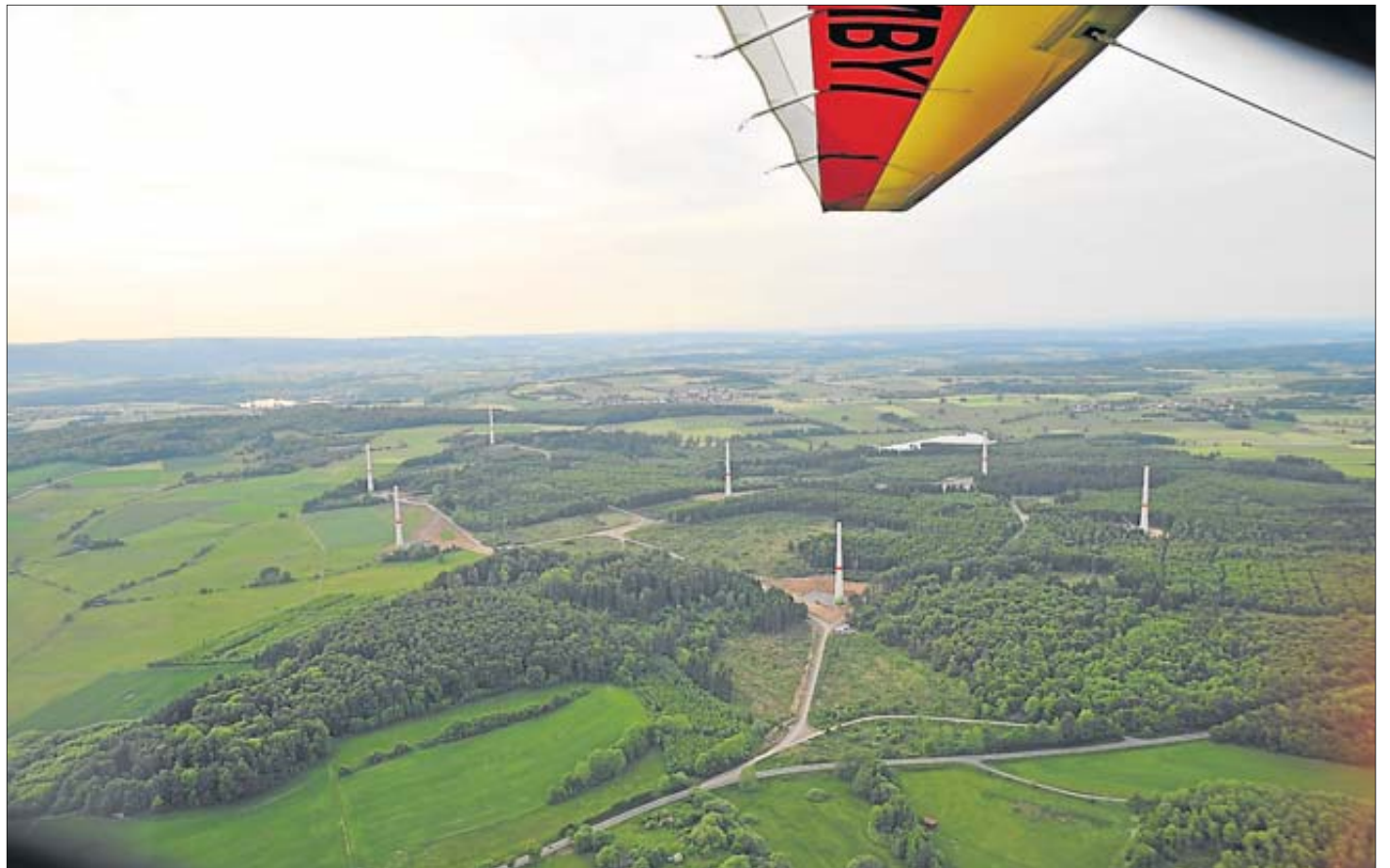
Auf dieser Luftaufnahme der Freiensteinauer CDU, die die Gemarkung Hallo bei Freiensteinau zeigt, sind die Rodungsflächen für den Windpark gut zu sehen. Teile davon werden nach Ende der Bauarbeiten wieder aufgeforstet. Foto: privat
